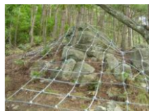
ケーブルネット ワイヤとクリップの締結で落石の発生を抑制
